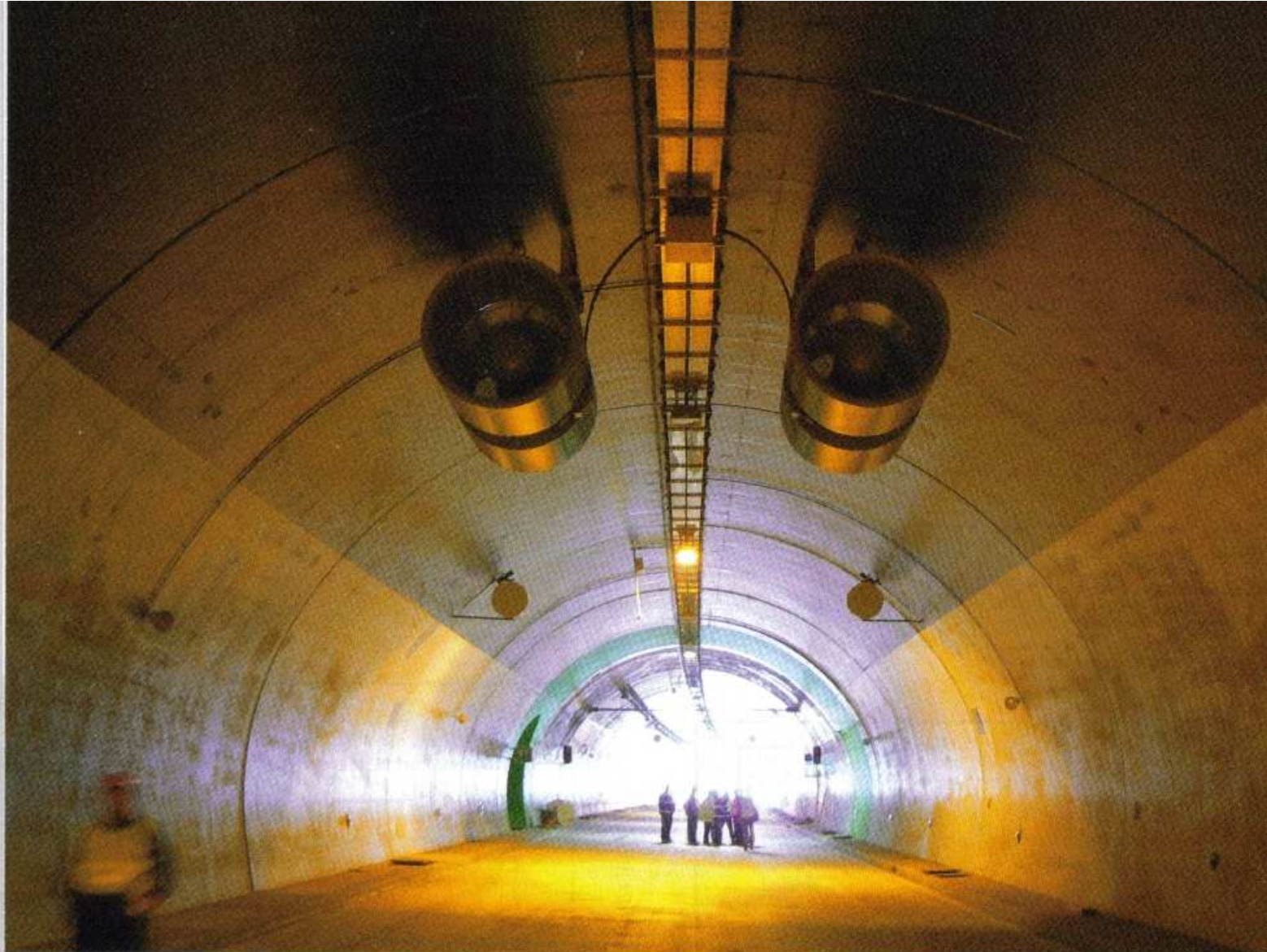
▲ Obr. 10. Dvojice proudových ventilátorů v tunelu Klimkovice
